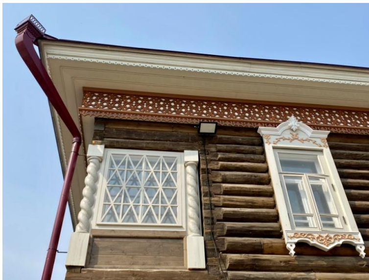
Рис. 5. Веранда с витыми деревянными колоннами и сохранившимся отреставрированным деревянным «кружевом». 2021 г.
