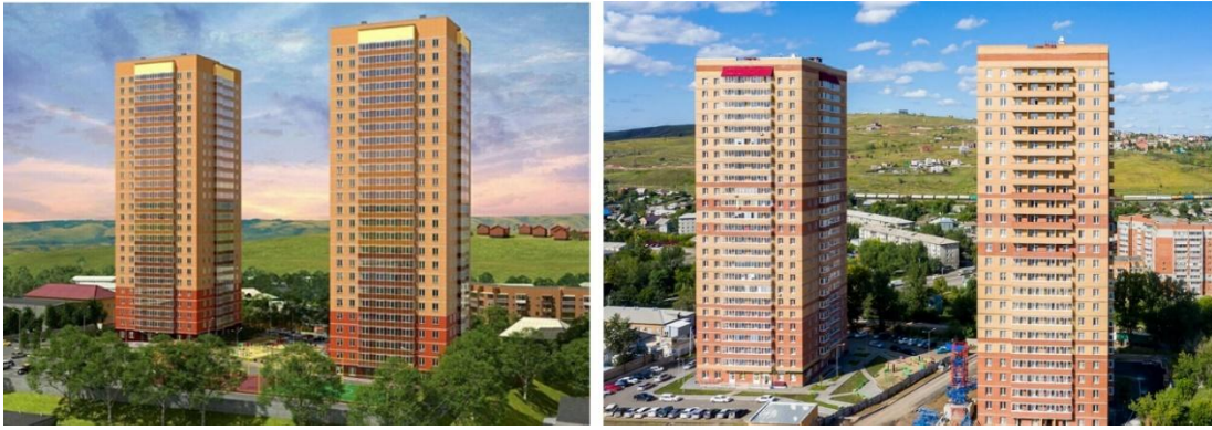
Рис. 4. ЖК «Уютный дом»: визуализация и реализация [2]
