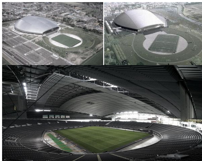
Рис. 2. Перемещающееся поле стадиона «Саппоро Доум» в Японии. 2002 г.
