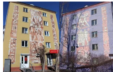
Рис. 3. Монументальные композиции в технике сграффито на фасадах жилых домов. Красноярск [7]
