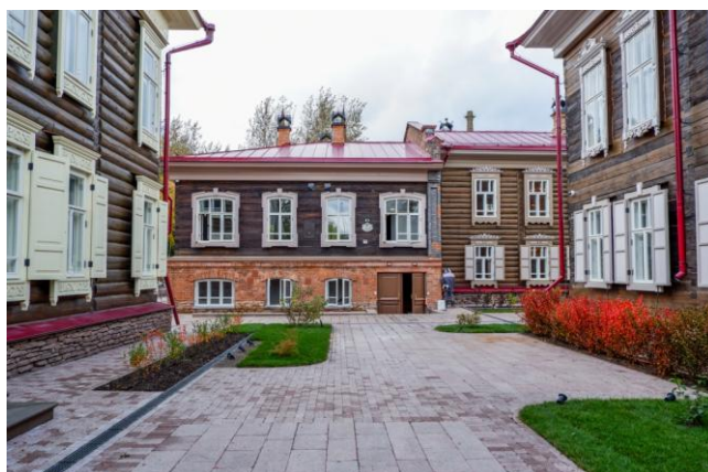
Рис. 3. Внутренний двор с видом на объекты культурного наследия «Флигель Н. М. Королёвой (кирпич, дерево)», 1904 г. и «Флигель усадьбы купца С. В. Телегина», 1900-е гг. до 1910 г. Фото 2021 г.
