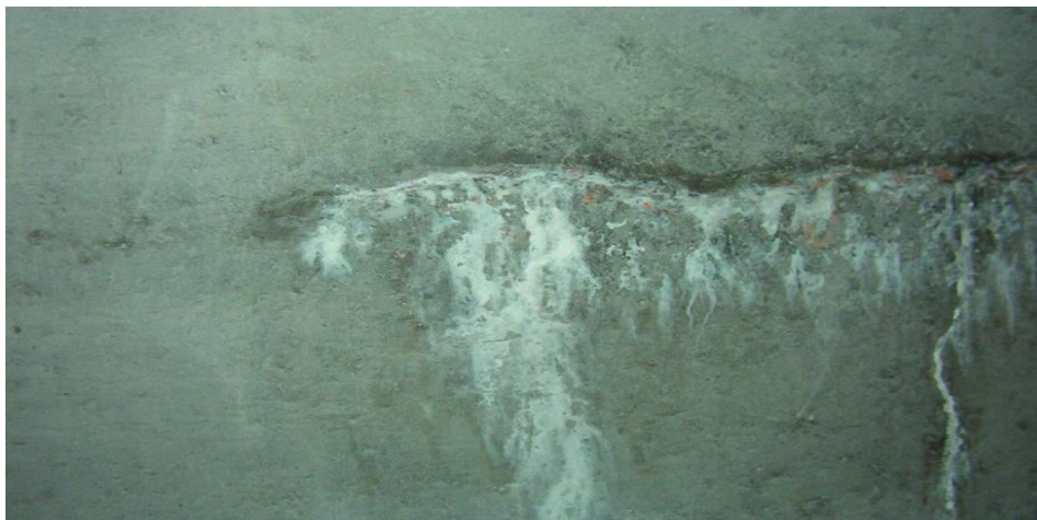
Рис. 5. Выщелачивание бетона
