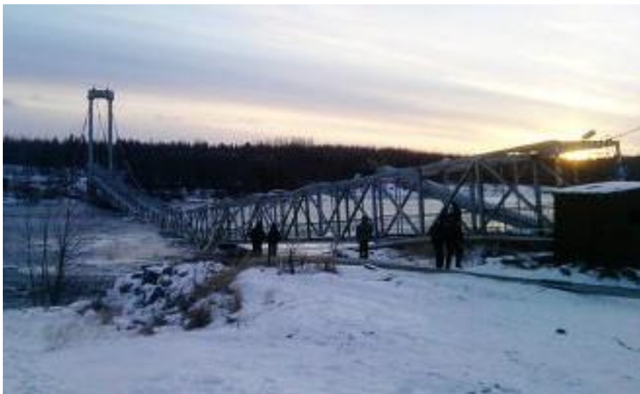
Рис. 1. Обрушение пешеходного моста через р. Кель у пос. Гайжево в Карелии. Взято из открытых источников
