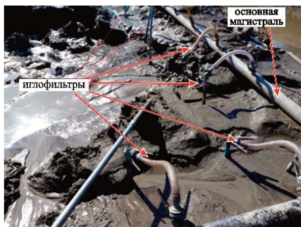
Рис. 5. Двухъярусное (по глубине) размещение иглофильтров.
