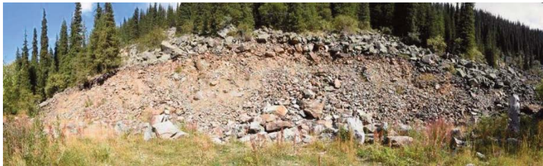
Рис. 5. Небольшой карьер в центральной части завальной плотины Большого Алматинского озера в борту которого отчетливо видно, что крупно-глыбовая панцирная фация отложений имеет мощность, фактически, «в одну глыбу» и подстилается интенсивно раздробленным щебнем того же состава без видимой переходной зоны.
