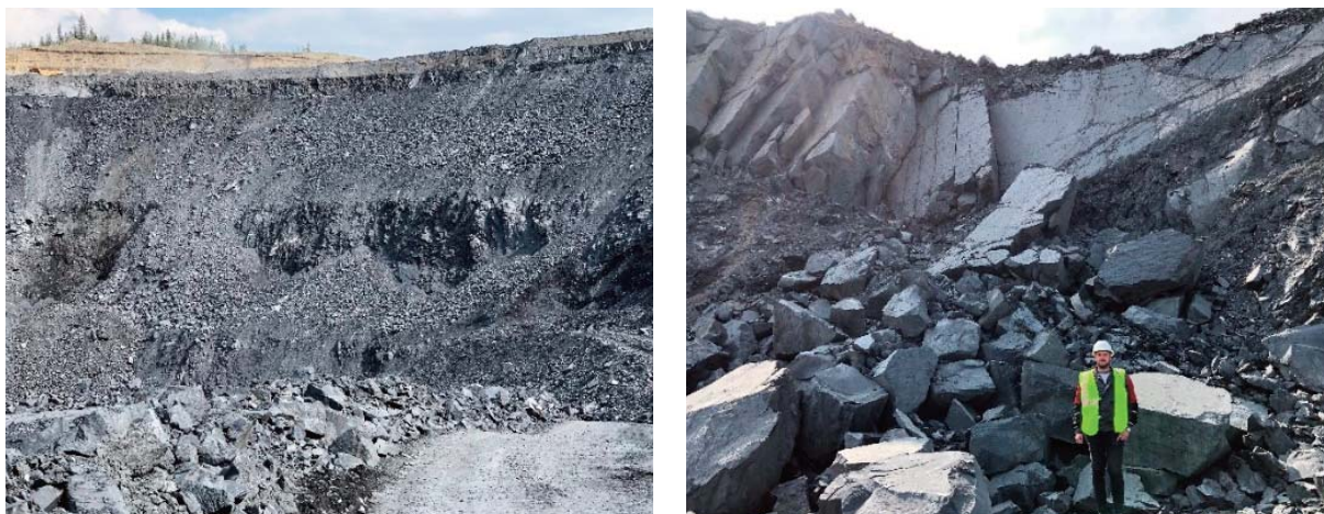
Рис. 1. Осыпь (слева), вывал (справа) в борту карьера.
