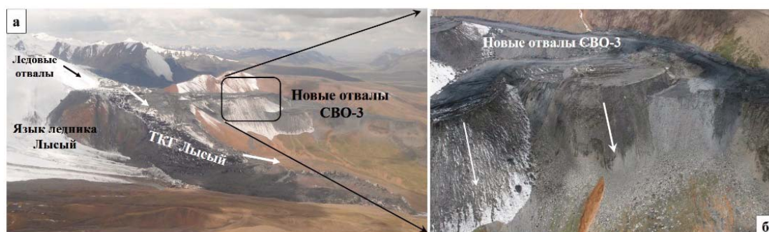
Рис. 3. Отвалы и техногенный каменный глетчер в бассейне ледника Лысый: а) общий вид ТКГ и каменно-ледовых отвалов; б) трещины на новых отвалах СВО-3, отсыпанных непосредственно на склоне.
