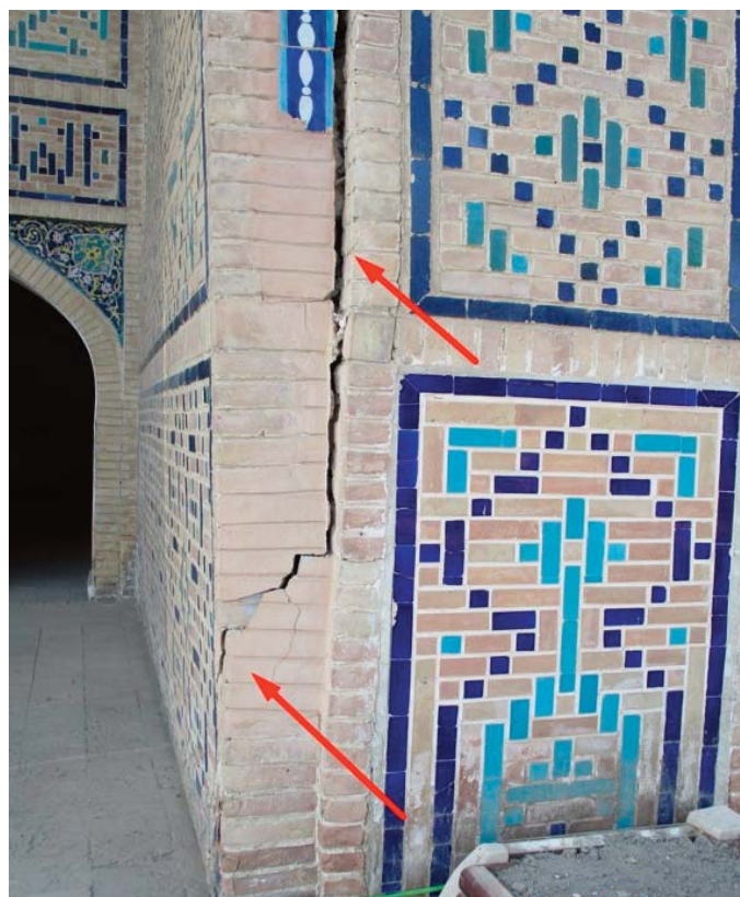
Рис. 1. Пример деформации реставрированного памятника архитектуры. Стена мечети Калян, главной действующей мечети г. Бухара (XV в.).
