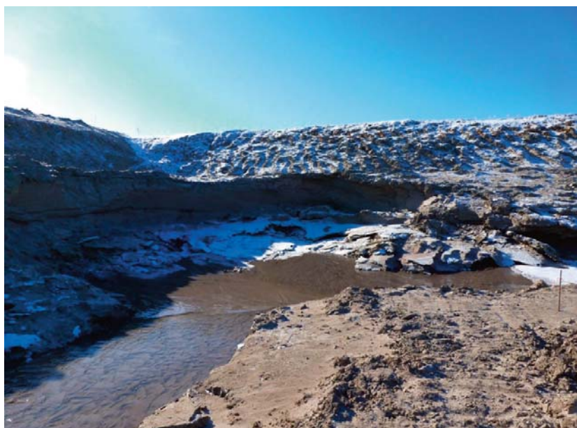
Рис. 4. Осложнения при строительстве (котлован электрохозяйства).
