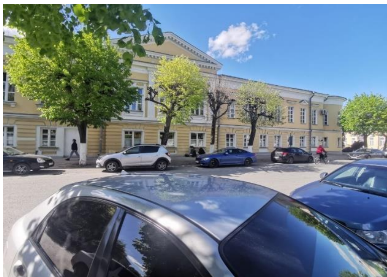
Рисунок 1- Здание института со стороны улицы Право - Лыбедская Жилой фонд такого типа широко распространен в центре Рязани.
