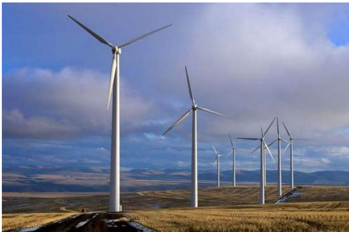
Рисунок 1. Общий вид ветроэлектрических установок
