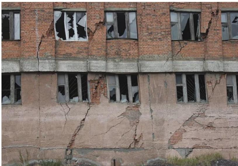
Рис. 1. Разрушенное здание вследствие деградации многолетней мерзлоты
