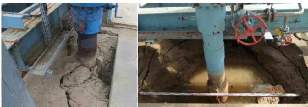
Рис. 2 – Просадка грунта в приустьевой зоне добывающих скважины
