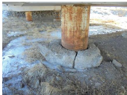
Рис. 4. Воздействие пучения на опору моста через руч. Смоленка
