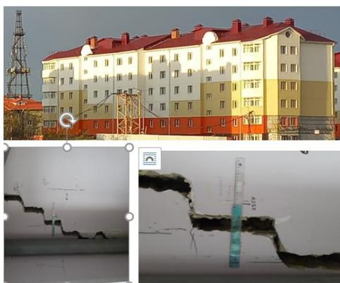
Рис.1 Деформации, вызванные осадкой при оттаивании грунтов основания дома мкр. Нефтяников дом 8, г. Новый Уренгой (фото С.В. Бомкина).
