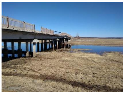
Рис. 3. Воздействие пучения на опору моста через р. Монгой
