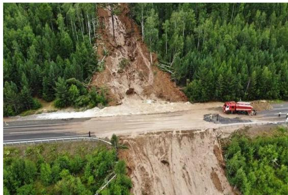
Рис. 6. Оползень-поток на 17 км трассы «Амур» (2018 г.)
