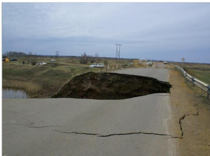
Рис. 1. Разрушение автодороги в связи с активизацией процесса термоэрозии.
