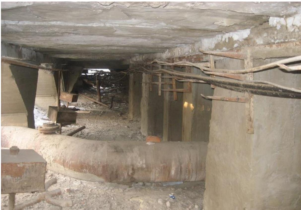
Рис. 2. Проветриваемое подполье под главным корпусом ЯТЭЦ.
