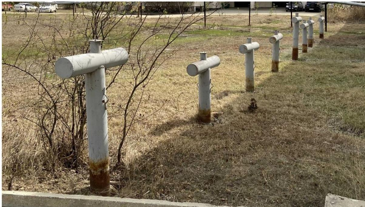
Рисунок 2 – Сезоннодействующие замораживающие установки вдоль переходной надземной галереи.
