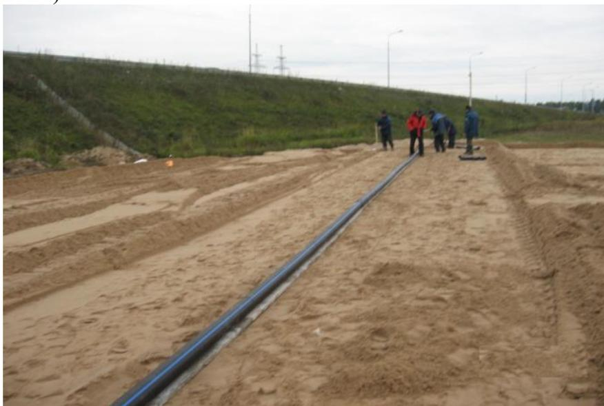
Рисунок 1 - Устройство инклинометрического измерительного канала при строительстве кольцевой автодороги вокруг Санкт-Петербурга в 2008 г.
