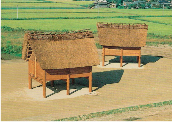
Рис. 8. Свайная конструкция. Реконструкция. Городище Ёсиногари, преф. Сага. [Кангō сёраку Ёсиногари исэки гайхō. С. 40].
