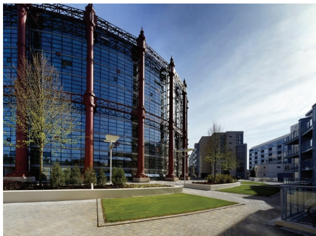
Рис.4 – Ревитализация колонного газгольдера в Дублине .
