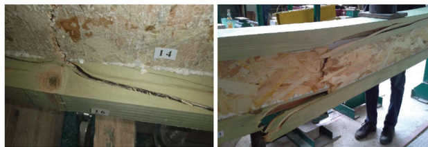
Рис. 4 Места разрушения балок Б-1 и Б-2
