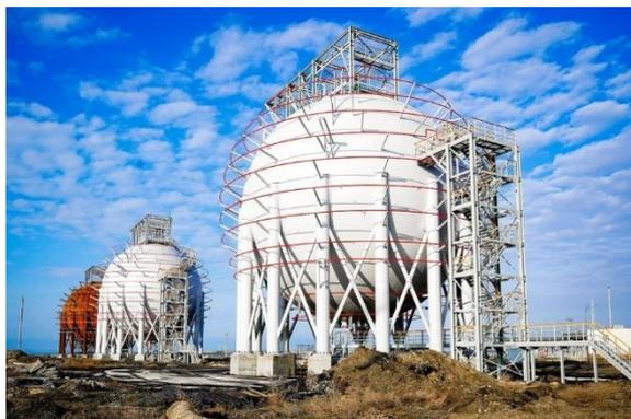
Рисунок 1 – Шаровые резервуары объемом 5000 м<sup>3</sup>
