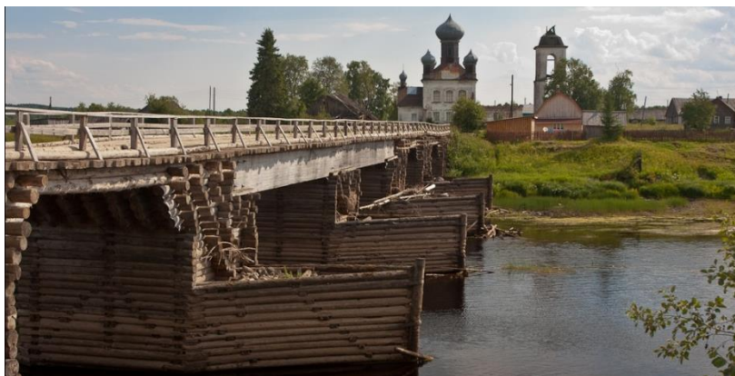
Рисунок 5. Пятипролетный ряжевый мост на р. Кене
