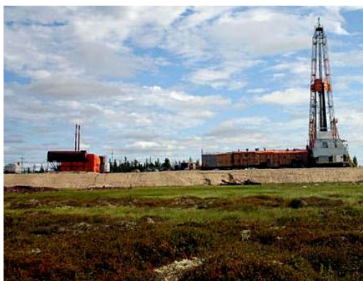
Расположение шламового амбара в теле кустовой площадки. Отсыпанная площадка на торфянике. Скв. 180 Пырейного ЛУ
