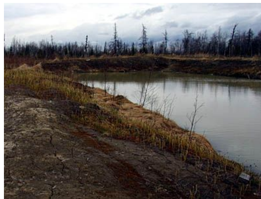
Расположение шламового амбара в заглубление в тяжелых по механическому составу грунтах. К-9 Берегового ЛУ
