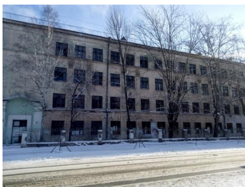
Рисунок 1 – Вид здания с центральной улицы
