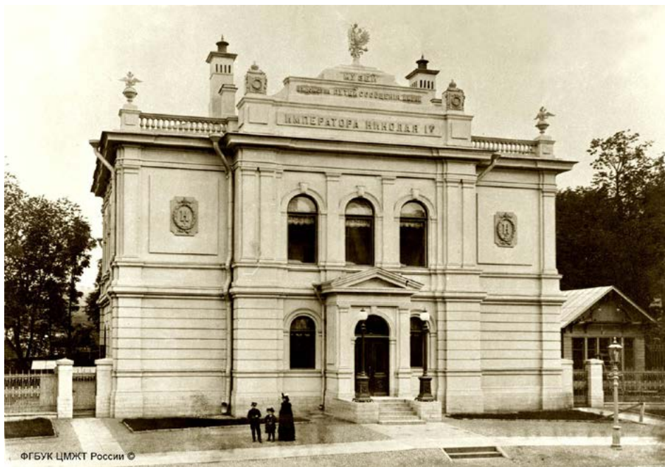
Рис. 1. Здание музея. 1902 г.
