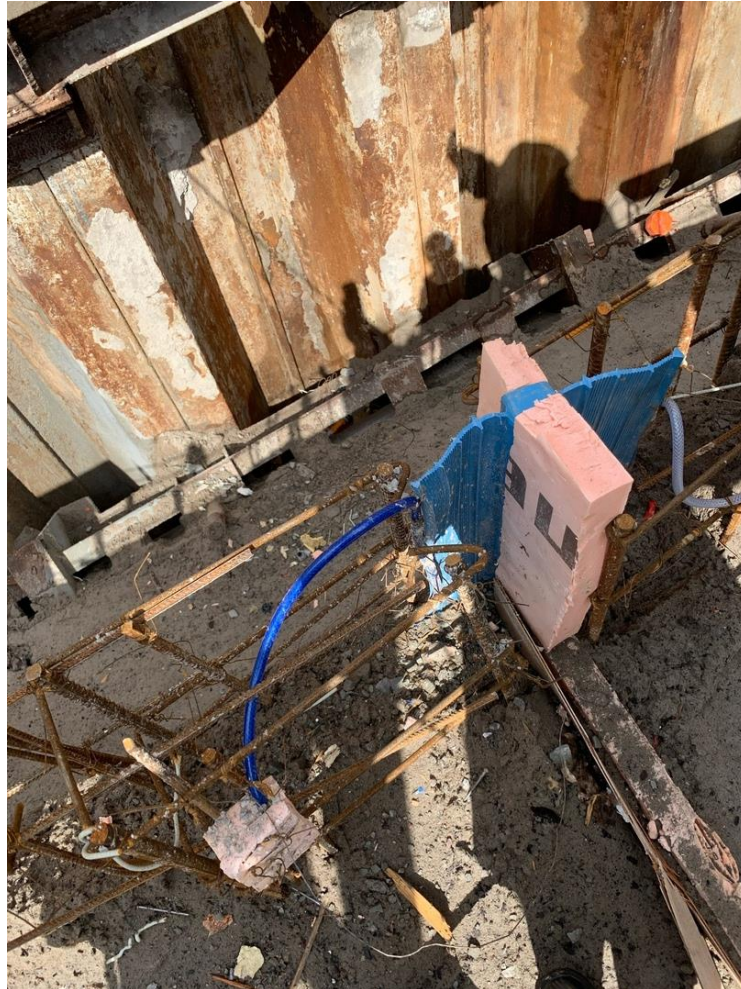
Рис.2 Инъектосистема совместно с гидротехнической шпонкой в шве Объект: ЖК «Neva Haus»
