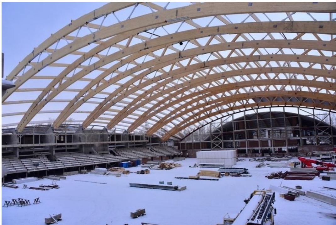
Рисунок 1. Большепролётные деревянные конструкции стадиона «Енисей»
