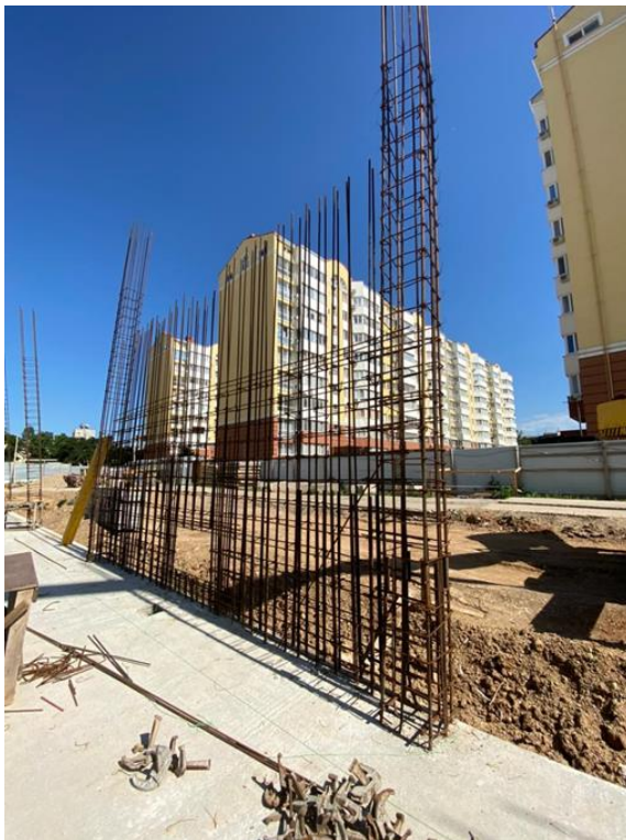
Рисунок 2 - Фотофиксация арматурных каркасов
