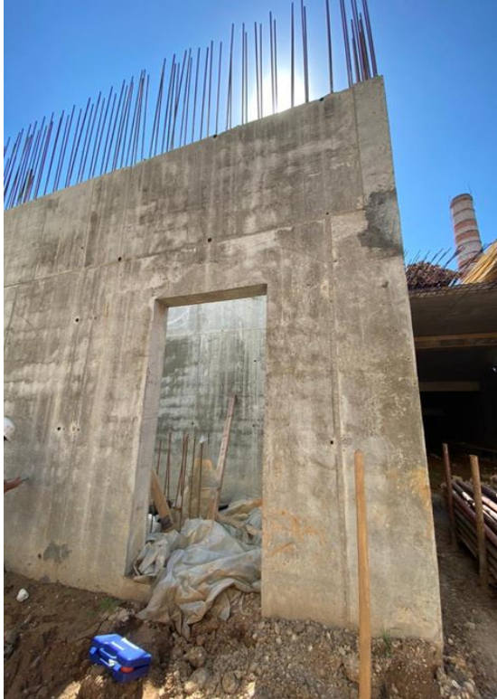
Рисунок 1 - Фотофиксация наружных стен
