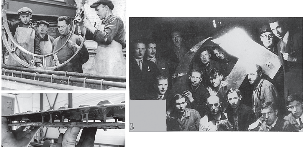
Рис. 2 1—процесс обшивки каркаса гербового знака «Серп и Молот» медными золочеными листами, 1935 г. Фото предоставлено Музеем истории Обуховского завода; 2—фрагмент гербового знака «Серп и Молот»: узлы крепления, вид сбоку; 3—бригада рабочих и мастеров завода «Большевик», принимавших участие в изготовлении гербовых знаков «Серп и Молот» (1935 г.). Фото предоставлено Музеем истории Обуховского завода
