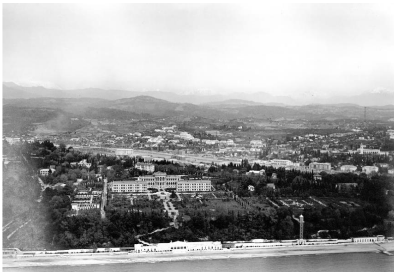
Рис. 3. Строительство новых санаториев в Сочи 1936 год
