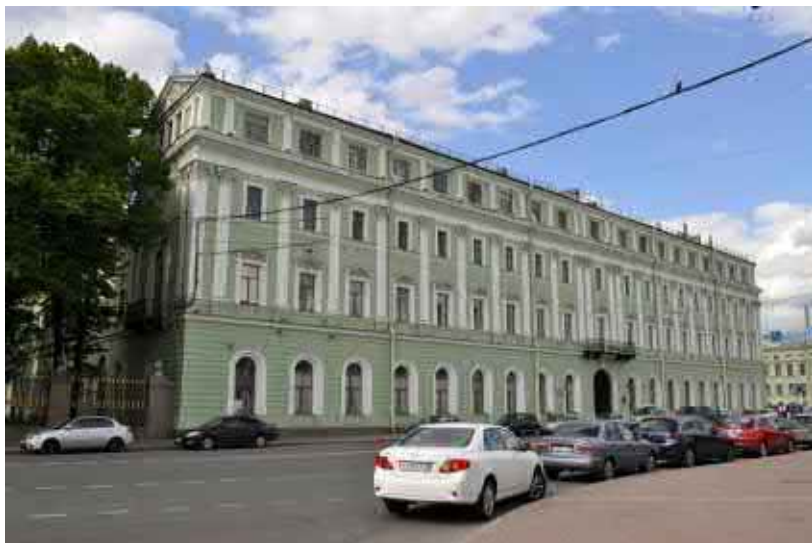
Рис. 5. Здание на Миллионной ул., д. 5, Санкт-Петербург 1768–1785 гг., 1844–1849 гг. (3 этаж и пилястры), 1932–1933 гг. (4 этаж)
