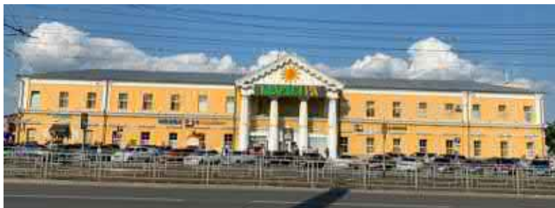
Рис. 14. Богадельня для инвалидов Сереброплавильного завода, Красноармейский проспект, д. 4, 1830–1840 гг., г. Барнаул
