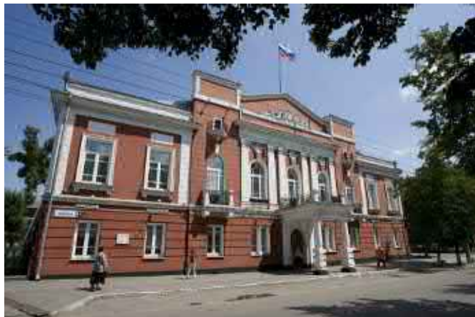
Рис. 8. Дом начальника Алтайского горного округа, ул. Ленина, д. 18, г. Барнаул, 1827 г.
