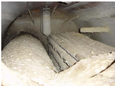
Рис. 2. Накипеобразование на котловом оборудовании [7]
