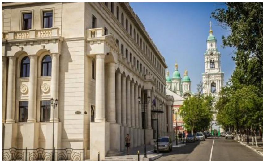
Рис. 2. Гостиница Новомосковская, г. Астрахань, современный вид
