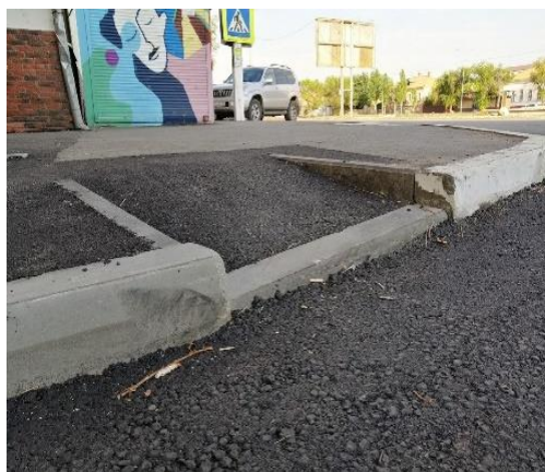
Рис. 7. Примеры нарушений при спусках с тротуаров
