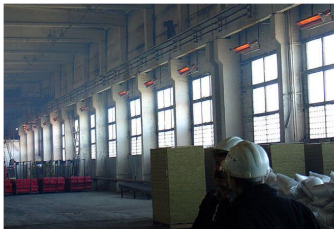
Рис. 2. Отопление промышленных зданий инфракрасными обогревателями
