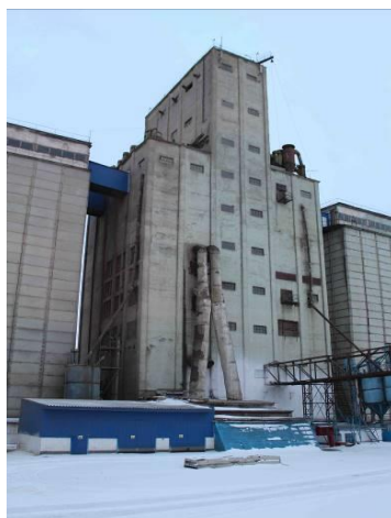
Рис. 2. Общий вид рабочей башни элеватора
