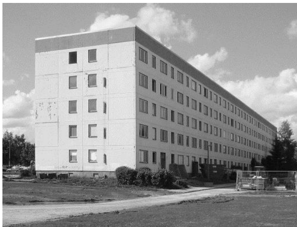
Рис. 1. Панельное здание в Германии до санации
