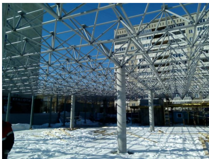
Рис. 3. Общий вид ПСПК междуэтажного перекрытия в процессе выполнения монтажных работ
