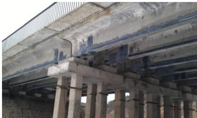
Рис. 1. Усиление пролетных конструкций системой внешнего армирования с применением композитных материалов
