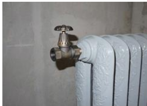
Рис. 3. Вентиль для дозированного мощности выпуска охлажденного воздуха
