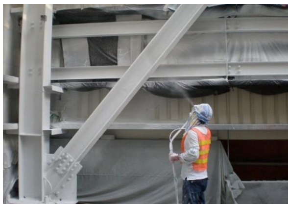
Рис. 3. Защита металла огнезащитными красками
