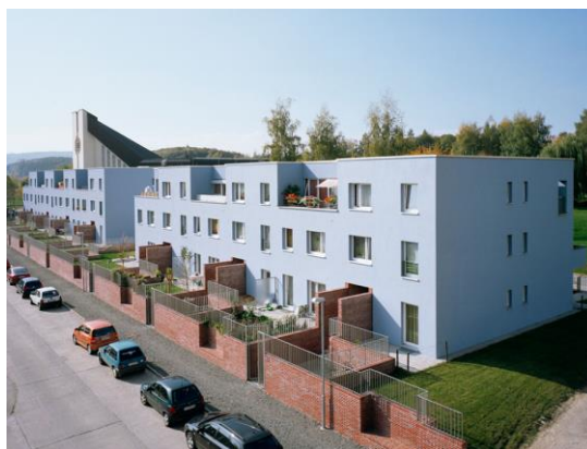
Рис. 3. Панельное здание с измененной этажностью после санации
