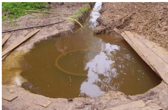
Рис. 2. Затопленный колодец [9]
