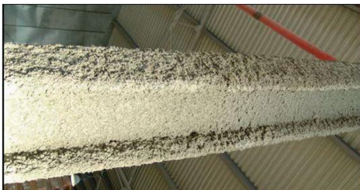
Рис. 2. Огнезащита шпаклевочным составом
