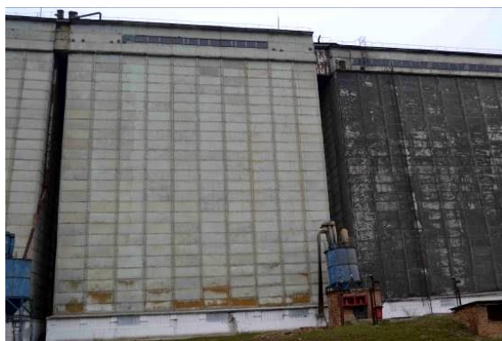
Рис. 3. Общий вид силосного корпуса
