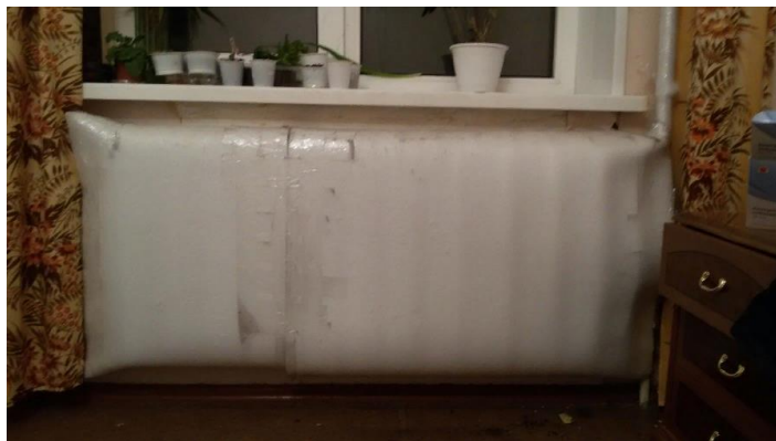
Рис. 4. Хладоаккумулирующий элемент (глицерин в полиэтиленовой упаковке) на батарее
