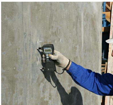
Рис. 3. Проведение измерений прочности бетона на участке монолитной железобетонной стены здания с помощью прибора УК-1401М
