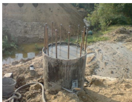
Рис. 2. Железобетонная свая – оболочка
