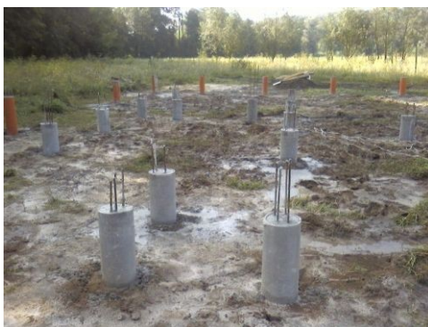
Рис. 3. Буроабивная свая
