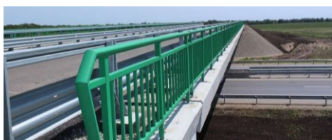
Рис. 1. Внешний вид перильного ограждения из стеклопластика на трассе обход г. Брянска, и поэлементная монтажная схема:
