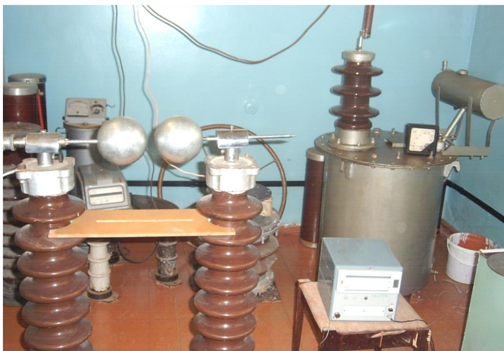
Рис.3. Установка для определения электрической прочности воздуха
