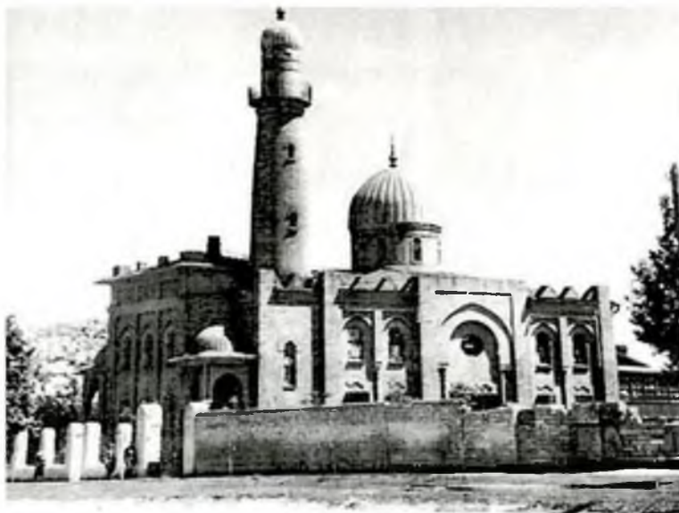
Рис. 2. Северный и западный фасады
