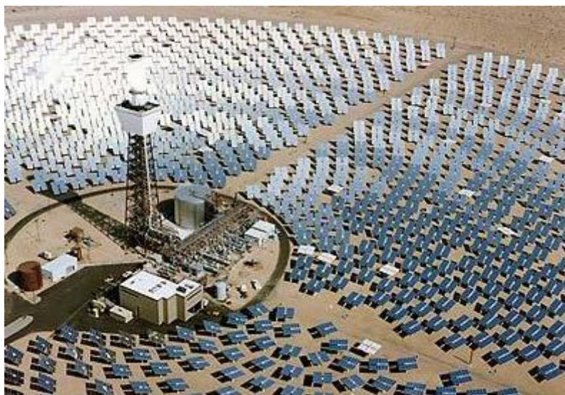
Εικόνα 3.1: Ηλιακός σταθμός Solar Two
