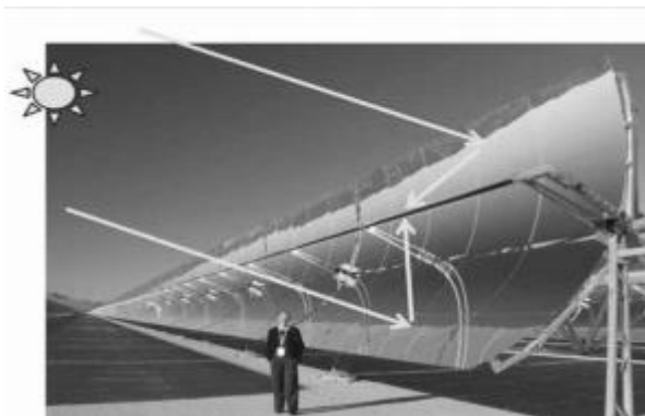
Εικόνα 2.1.2: Συγκέντρωση ηλιακής ακτινοβολίας από παραβολικούς συγκεντρωτές
