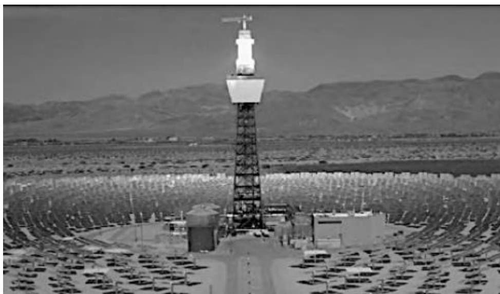
Εικόνα 2.1.7: Ηλιακός σταθμός Solar Two
