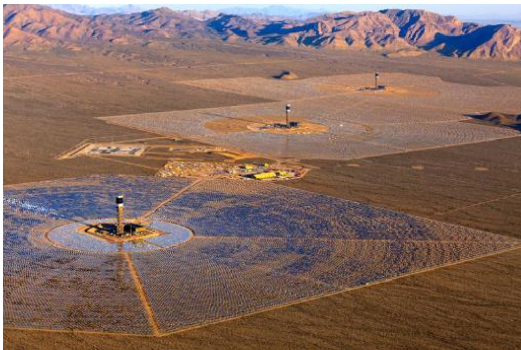
Εικόνα 3.5: Ηλιακός σταθμός Ivanpah Solar Electric Generating System
