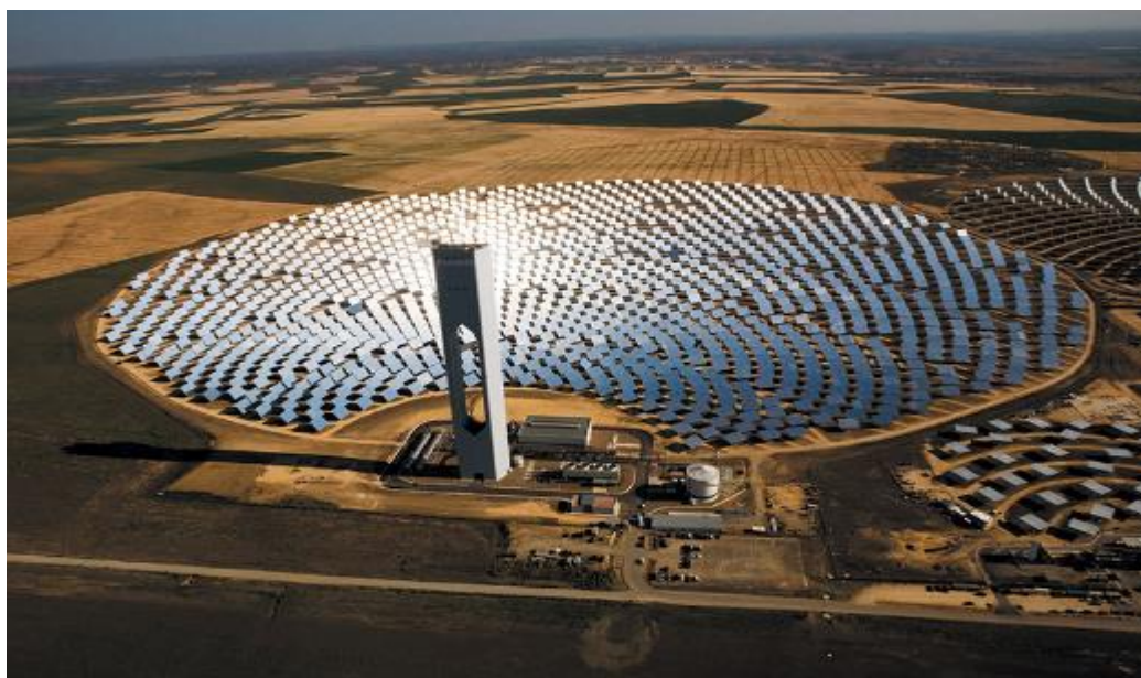
Εικόνα 3.4: Ηλιακός σταθμός PS10
