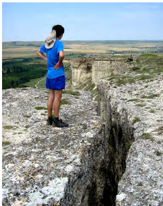
Рис. 82. У одной из трещин бокового отпора на вершине горы Ак-Кая. Фото В.В. Аркадьева
