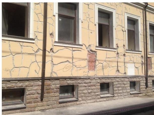
*Рисунок 7 – Нарушение технологии устройства фасадной системы мокрого типа – не использовали армирующую сетку, что привело к полному растрескиванию фасада*
