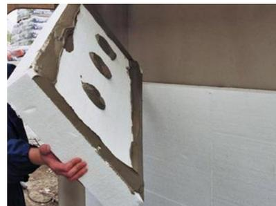
*Рисунок 4 – Нанесение клеевых составов для теплоизоляционных панелей не должно выполняться по всей поверхности, а на 2-3 мшени (правильный вариант технологии – справа)*
