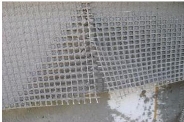
*Рисунок 6 – Нарушение технологии в укладывании армирующей сетки: минимальный перехлест между полотнами сетки – 10 см*
