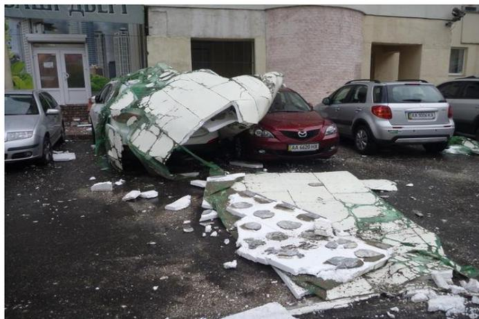
*Рисунок 5 – Не соблюдение температурных режимов производства фасадных работ: работы по устройству теплоизоляционных фасадных систем мокрого типа должны проводиться при температуре не ниже +5 °С*
