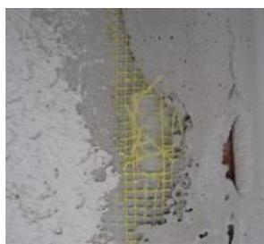
*Рисунок 8 – Использование армирующей сетки низкого качества*
