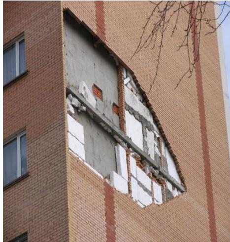
*Рисунок 3 – Нарушение технологии нанесения клеевых составов для теплоизоляции*
