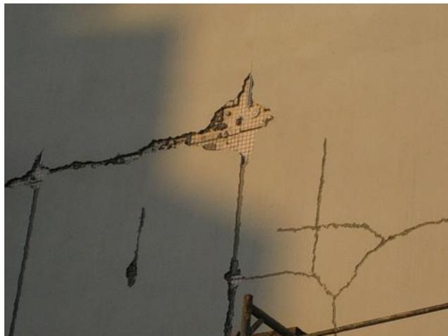
*Рисунок 2 – Осыпание финального слоя штукатурки вследствие использования не щелочестойкой армирующей сетки, которая практически полностью растворилась*
