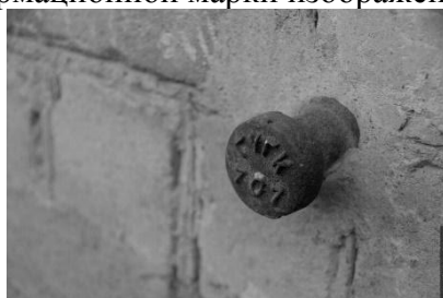
Рис. 2. Деформационная марка
