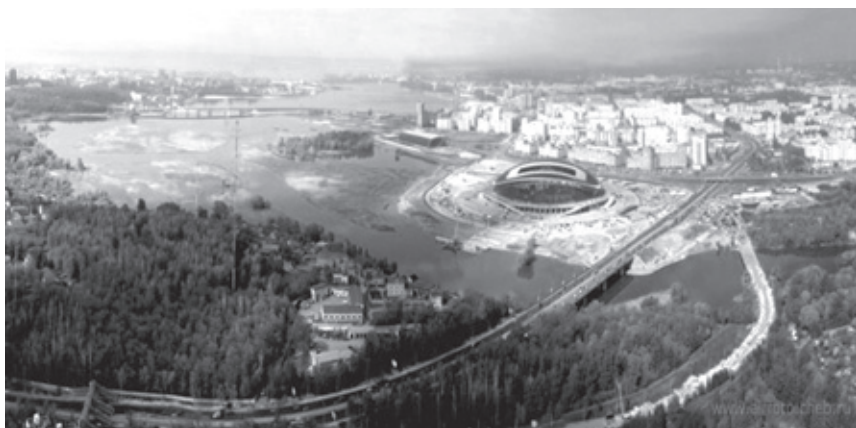
Рис. 2. Правый берег р. Казанки после строительства стадиона (2013 г.)
