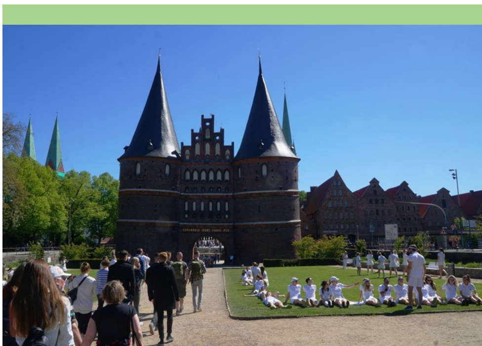
Das spätgotische Holstentor in Lübeck als einstiger Teil der Stadtbefestigung
