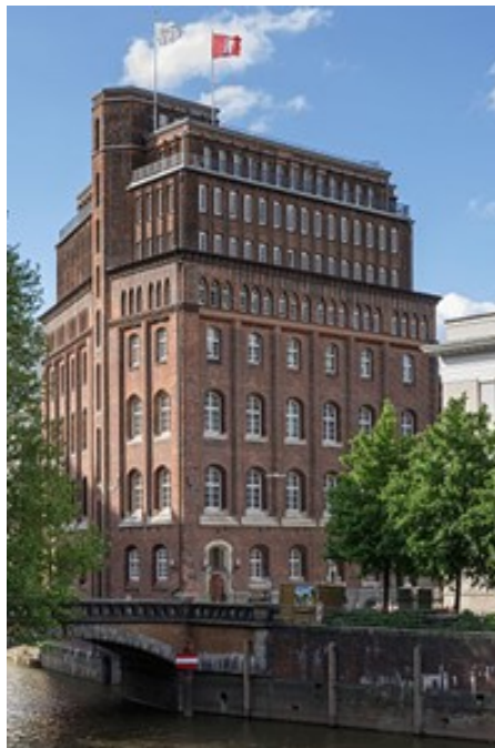
Das Gebäude der Patriotischen Gesellschaft in Hamburg an der Trostbrücke
