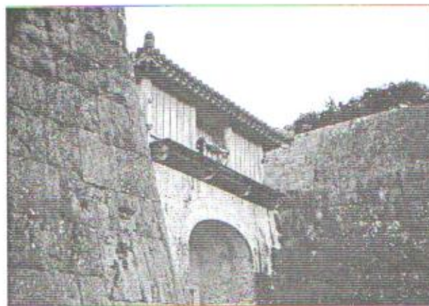
Рис. 11. Стены средневековой крепости, сложенные из кораллового известняка (остров Окинава) [8].
