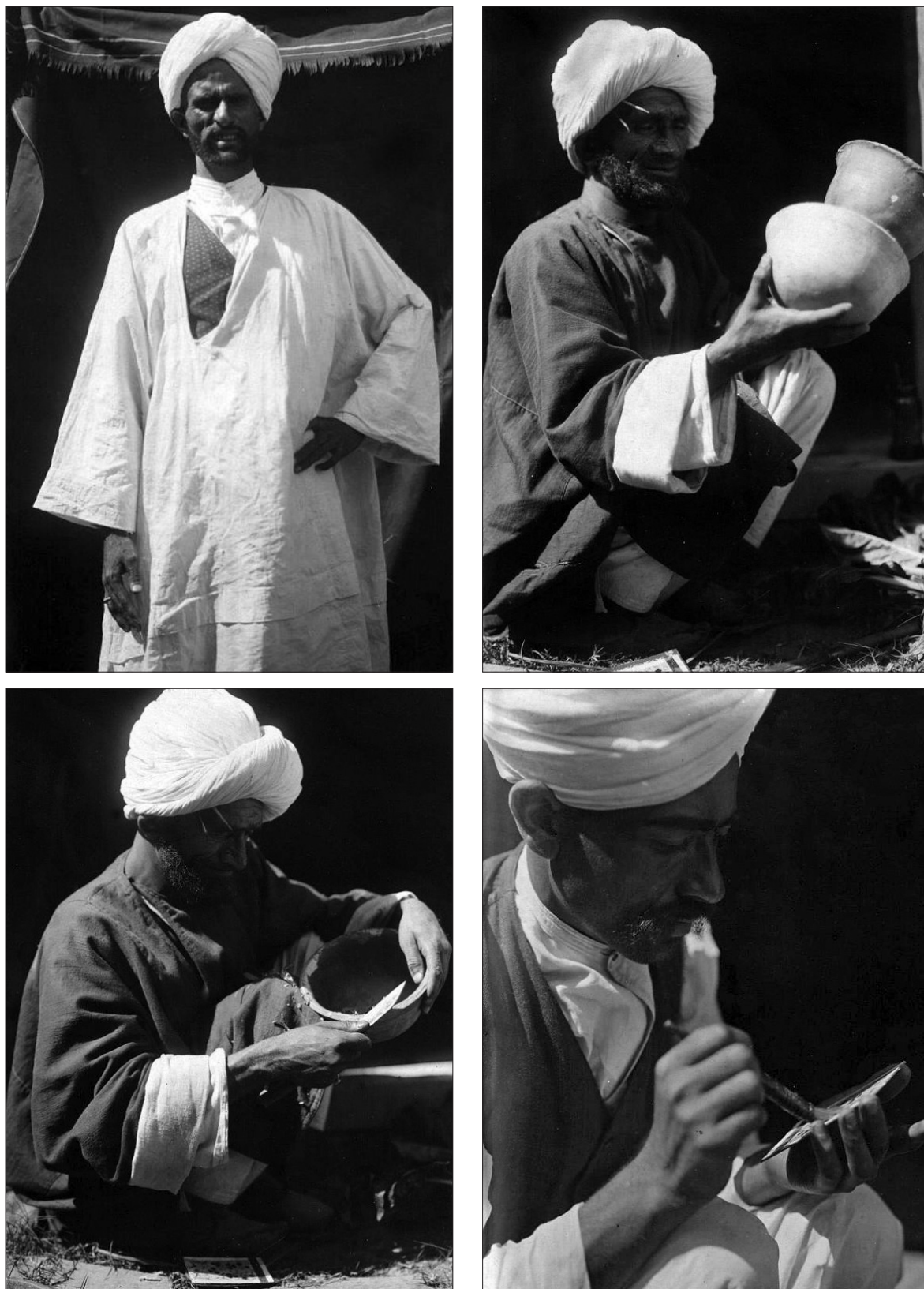
Рис. 1. Фотографии, сделанные в мастерской папье-маше (Шринагар): а — Абдул Азиз, владелец мастерской; б — снятие заготовки изделия с модели; в — срезание с краев изделия излишков бумажной массы; г — художник за работой над росписью
