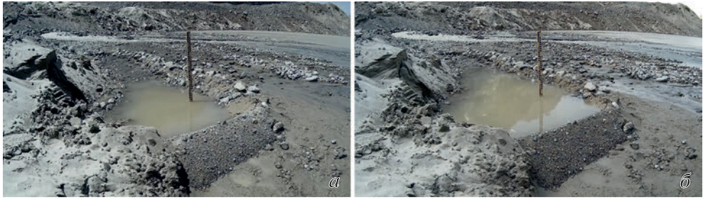
Рис. 4. Сравнение оттенков моренной плотины в период наполнения водоема (а) и при максимальном уровне воды в нем (б).
