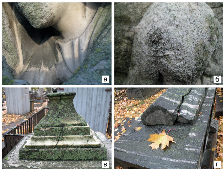
Рис. 2. Различные формы повреждений камня: а- обогащенная гипсом патина на белом мелкозернистом мраморе; б- дезинтеграция поверхности камня вследствие выкрашивания; в, г- трещины и сколы, грязевые наслоения.
