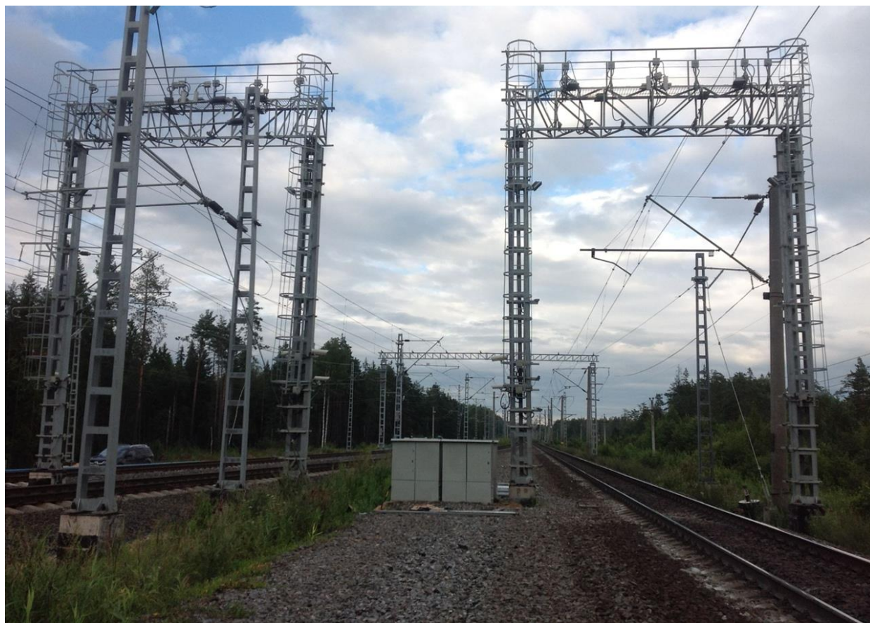
Рис. 1. Ворота автоматической диагностики технического состояния подвижного состава и коммерческих неисправностей
