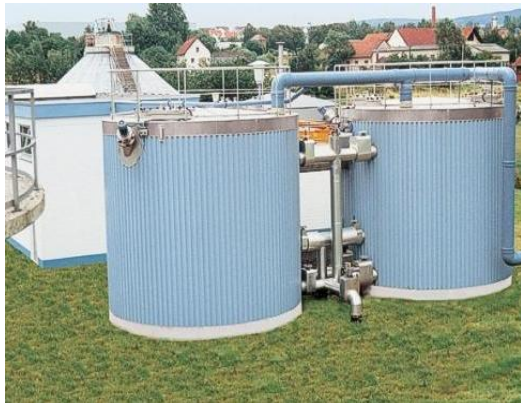
Fig. 1. Conventional ATAD system (source Fuchs Gas- und Wassertechnik GmbH web page)
