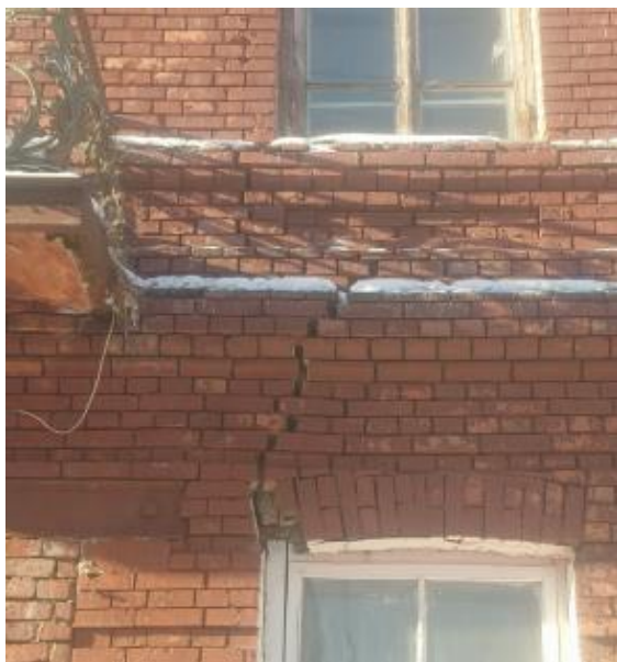
Рисунок 2 – Повреждения исторических кирпичных зданий в результате биопоражения гниением деревянных элементов фундаментов
