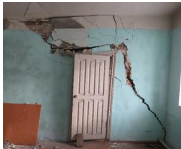
Рисунок 2 – Повреждения исторических кирпичных зданий в результате биопоражения гниением деревянных элементов фундаментов
