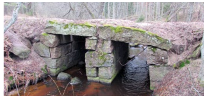
Каменный арочный мост через р. Лососинку. Фото А. Ю. Дорониной
