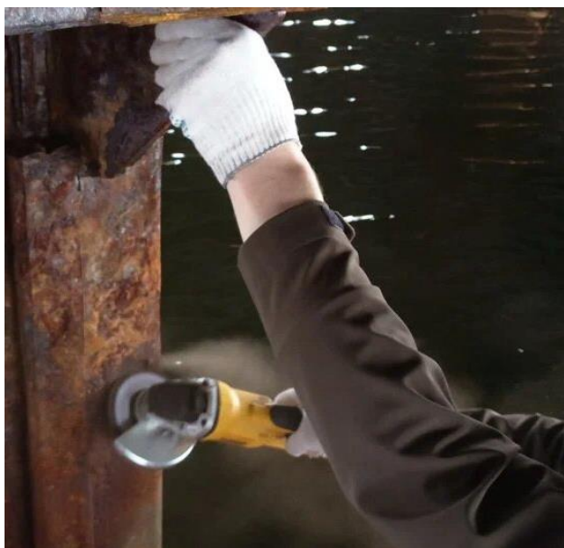
Рис. 2. Подготовка поверхности
