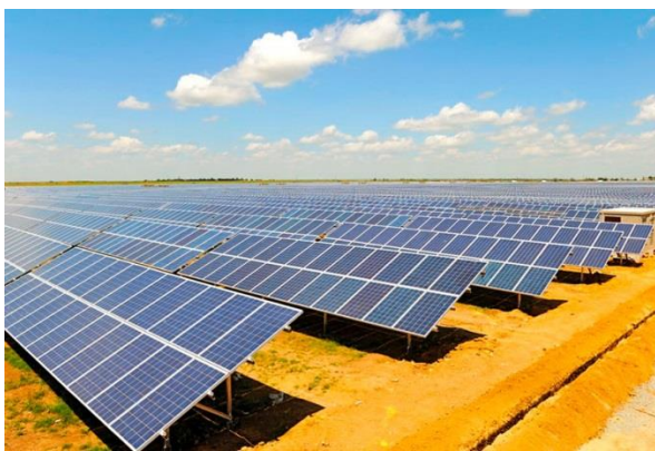
Рис. 1. СФЭС мощностью 100 МВт в Карманинском районе Навоийской области
