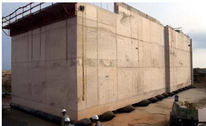
Рис. 1. Транспортировка массива-гиганта с применением воздушных подушек
