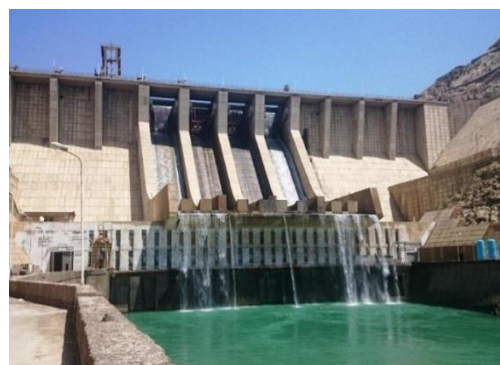
Рис. 4. Здание ГЭС Наглу
