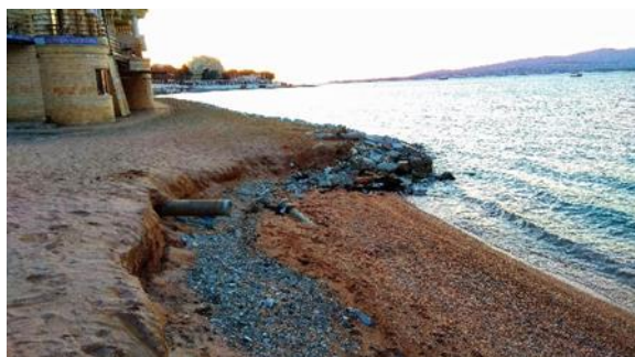
Рис. 3. Дренажные (или канализационные) трубы в районе Центрального пляжа
