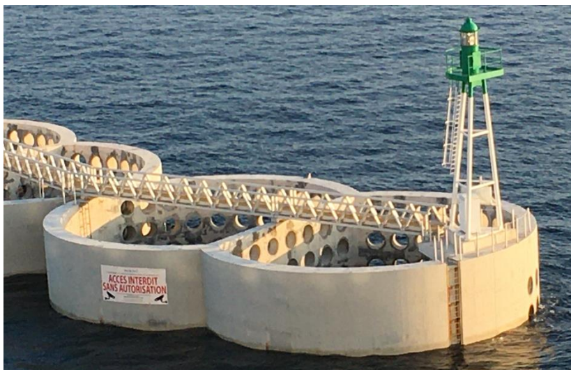
Рис. 4. Головная часть мола из перфорированных массивов-гигантов
