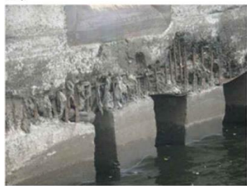
Рис. 3. Коррозия бетона:
