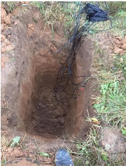
Рисунок 1. Шурф для установки грунтовых датчиков, составлено автором
