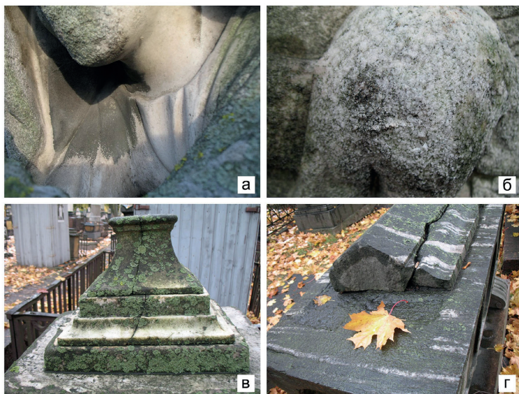
Рис. 2. Различные формы повреждений камня: а- обогащенная гипсом патина на белом мелкозернистом мраморе; б- дезинтеграция поверхности камня вследствие выкрашивания; в, г- трещины и сколы, грязевые наслоения.
