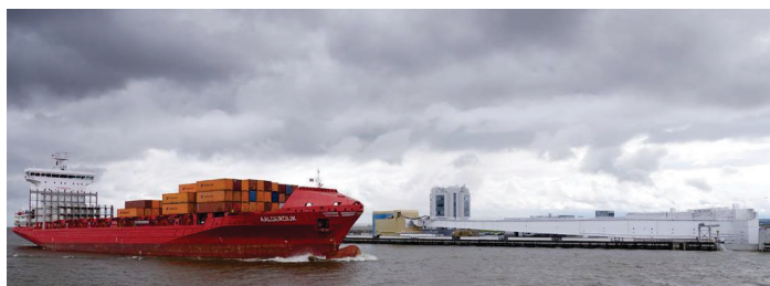
Рисунок 6.13 – Проход судна через судопропускное сооружение С-1
