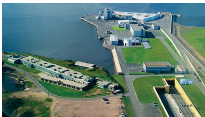
Рисунок 6.12 – Внешний вид судопропускного сооружения С-1. Сегментные затворы С-1: количество затворов/приводов, шт - 2 / 2; высота/ширина/длина батопорта, м - 22 / 8,3 / 119,6; масса/объем плавучести батопорта - 2938 т / 3914 м 3 ; радиус движения, м – 130; глубина погружения, м – 16
