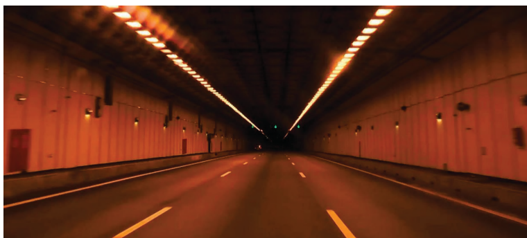
Рисунок 6.7 – Участок КАД от о. Котлин до порта Бронка в автомобильном тоннеле под морским дном
