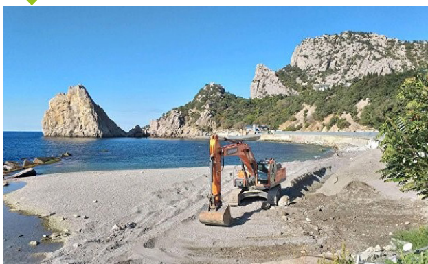
Рис. 3. Строительство берегоукрепительных сооружений на набережной пгт. Симеиз
