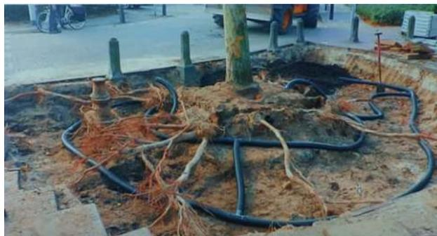
Рис. 2. Пример системы аэрации
