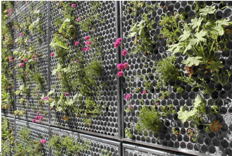
Рисунок 8 — Конструкция сот для вертикального озеленения.
