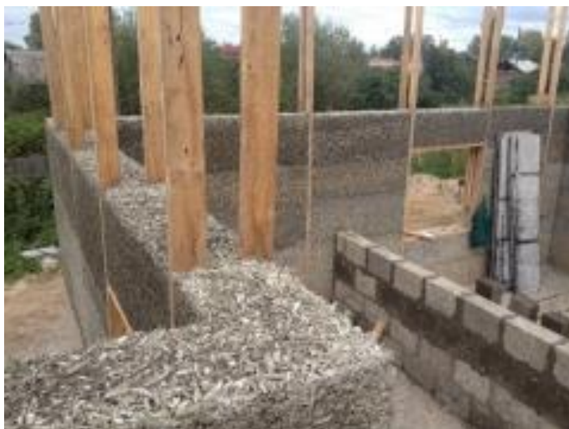
Рисунок 2 — Арболит построечного изготовления в сочетании с легким каркасом из досок.
