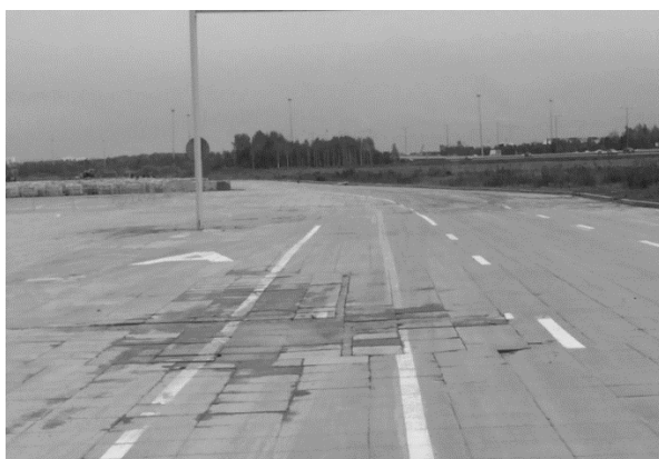
Деформации поверхности автопарковки
