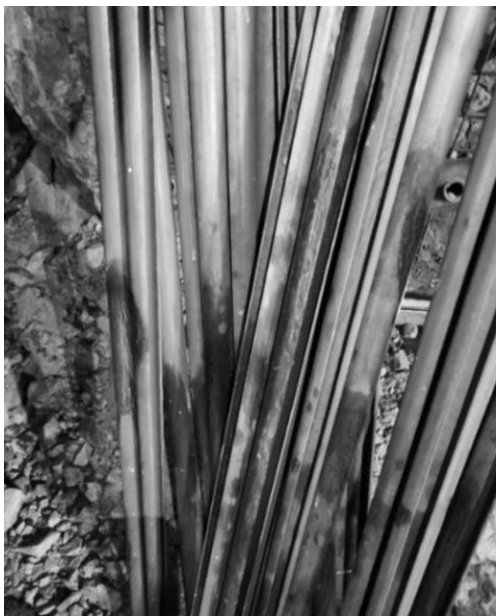
Рис. 1. Развитие коррозии на новых (неустановленных) анкерах под влиянием капеза подземных вод (фото автора от 15.05.2020)
