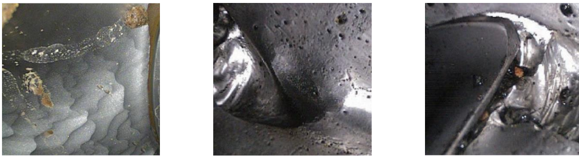
Рис. 1. Дефекты шнека транспортирующего конвейера.
