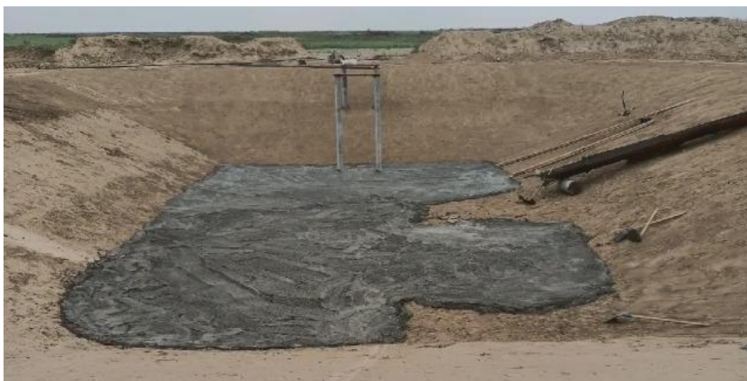
Рис. 6. Бетонирование дна водоёма
