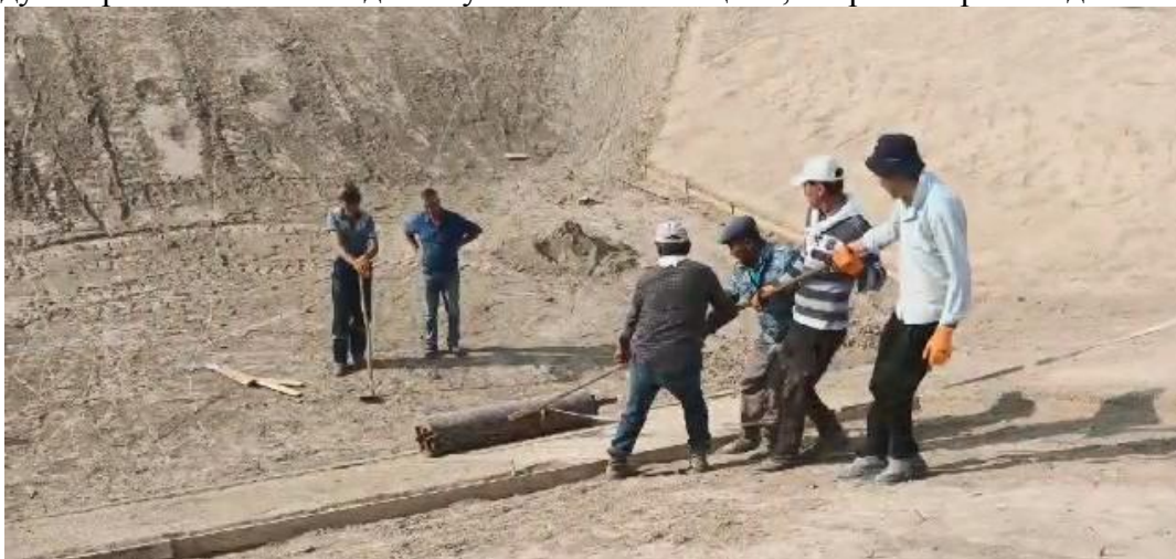
Рис. 5. Укатка ручным катком боковых откосов котлована
