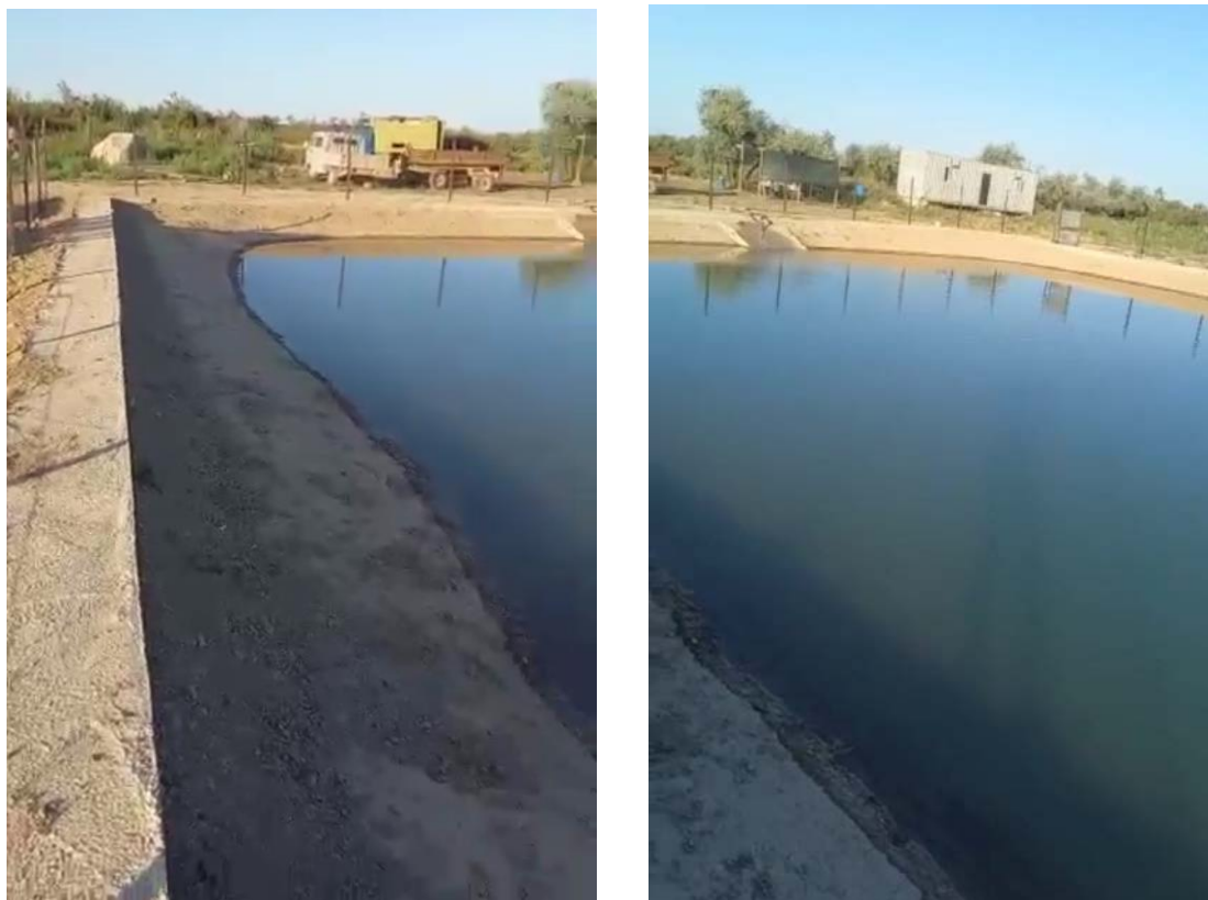
Рис. 7. Водоем в Отырарском районе Туркестанской области Республики Казахстан в процессе заполнения. Видна конфигурация береговых откосов, береговая бетонная отмостка, съезд в водоем, ограда водоема.
