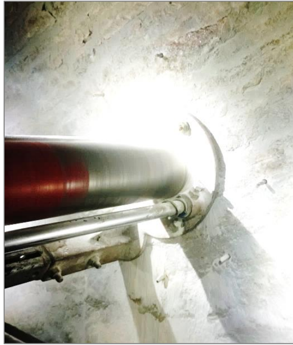
Рис. 2. Процесс бурения кольцевой щели на стенке горной выработки Главного восточного конвейерно-вентиляционного штрека №2
