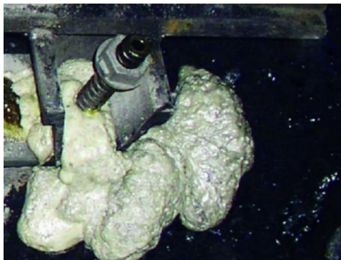
Рис. 1. Химическое анкерование пород кровли вспенивающимся составом
