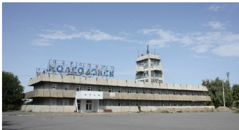
Рисунок 6 – Здание аэропорта «Волгодонск» [3]
