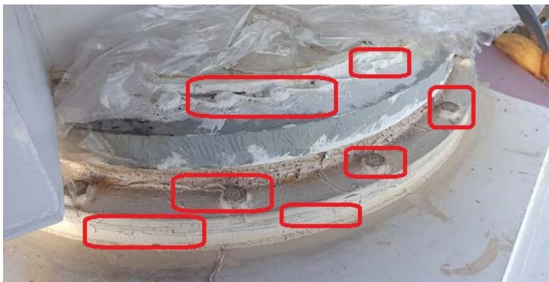
Рис. 3. Места протечек
