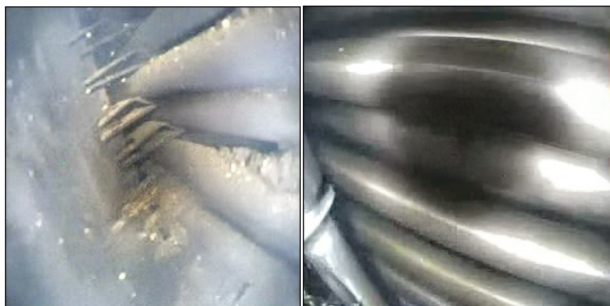
Рис. 4.46. Внешний вид оборудования ПГ до (а) и после (б) химической промывки
